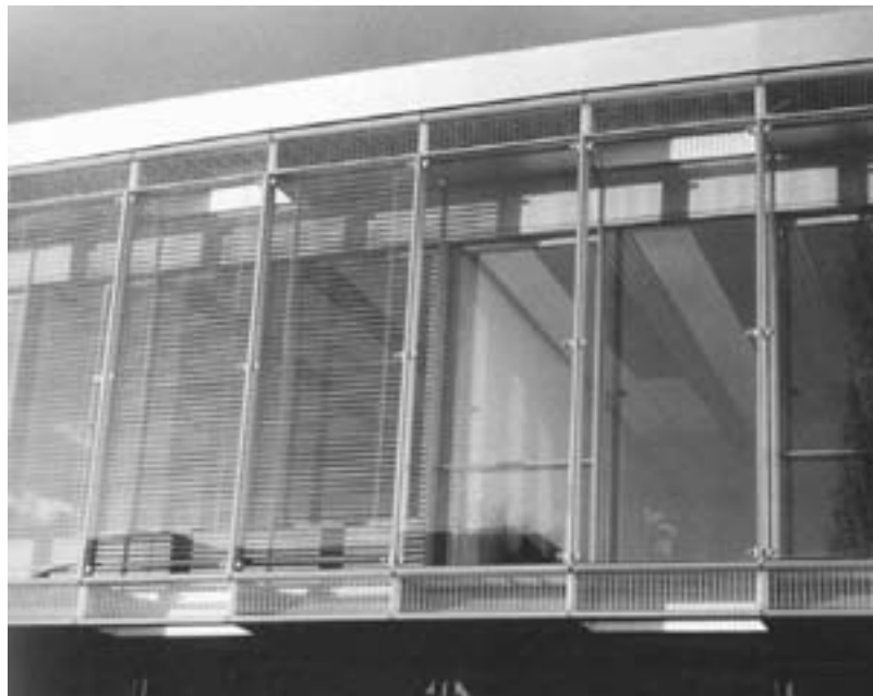
Slika 12: Model jaškaste vzorčne fasade za nebotičnik, Düsseldorf [Oesterle, 1998]
