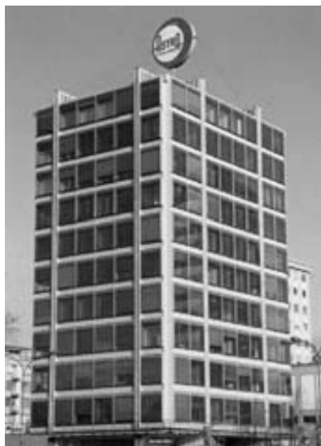
Slika 10: Astra, Ljubljana – škatlasta fasada [Schüco, Alukönigstahl]
