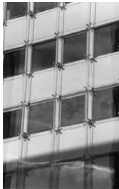
Slika 2: Fasada z dvema lupinama - IMP, Ljubljana, Dunajska cesta – steklena lupina pred masivnim zidom z okenskimi odprtinami [Schüco, Alukönigstahl]
