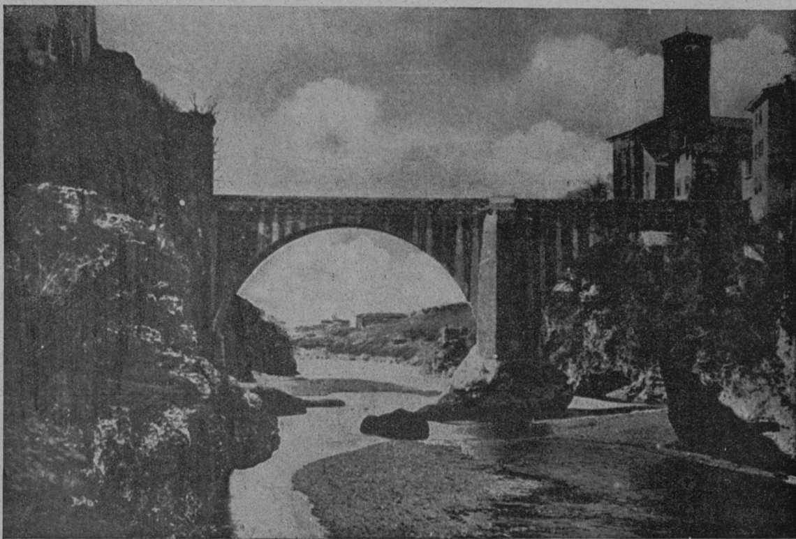
Vražji most v Čedadu preko reke Nadiže. — Most je bajè že iz 15. stoletja. Čedad šteje nad 10.000 prebivalcev ter je živahno središče beneških Slovencev zlasti ob sobotah.
