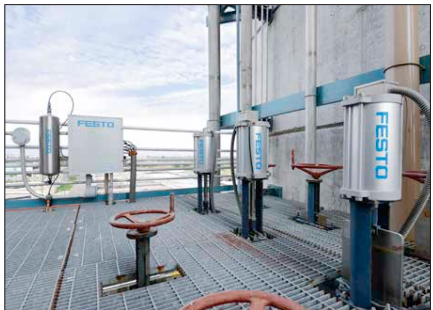
Slika 10. Pnevmatični pogoni za odpiranje in zapiranje procesnih ventilov (zapahov in loput) imajo pomembno prednost pred električnimi: trpežnost, dolge intervale vzdrževanja in varnost pri preobremenitvi. (Foto: Festo AG & Co. KG)
