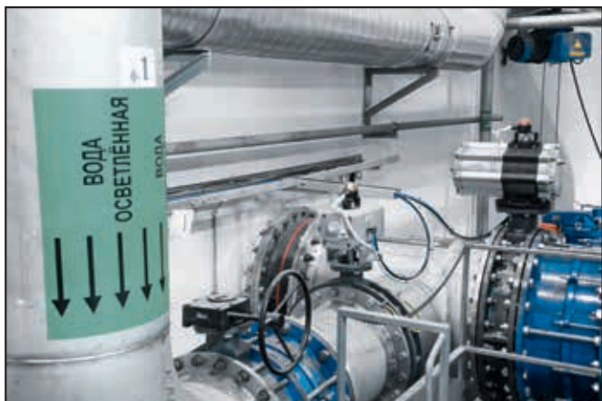
Slika 5. Pnevmatični pogoni različnih velikosti zagotavljajo zanesljivo odpiranje in zapiranje ventilov za dovod vode in splakovanje pri čiščenju peščenih filtrov. (Foto: Festo AG & Co. KG)
