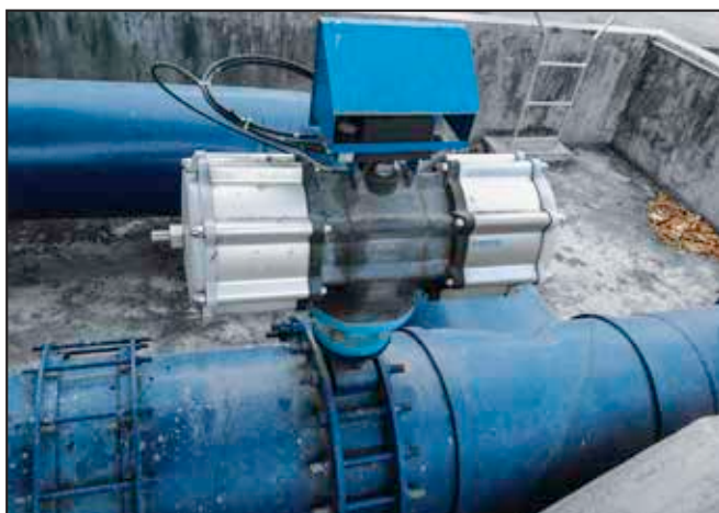
Slika 6. Dostavne črpalke so opremljene pogoni DAPS 8000, ki regulirajo dobavo vode uporabnikom. (Foto: Festo AG & Co. KG)
