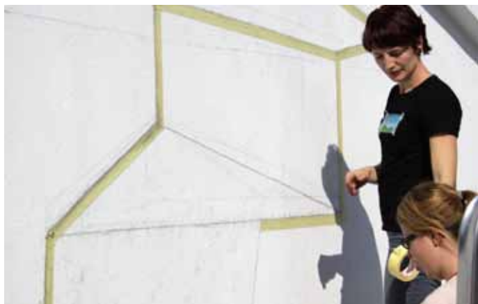
Slika 3: Priprava dela in zaščita linij.
