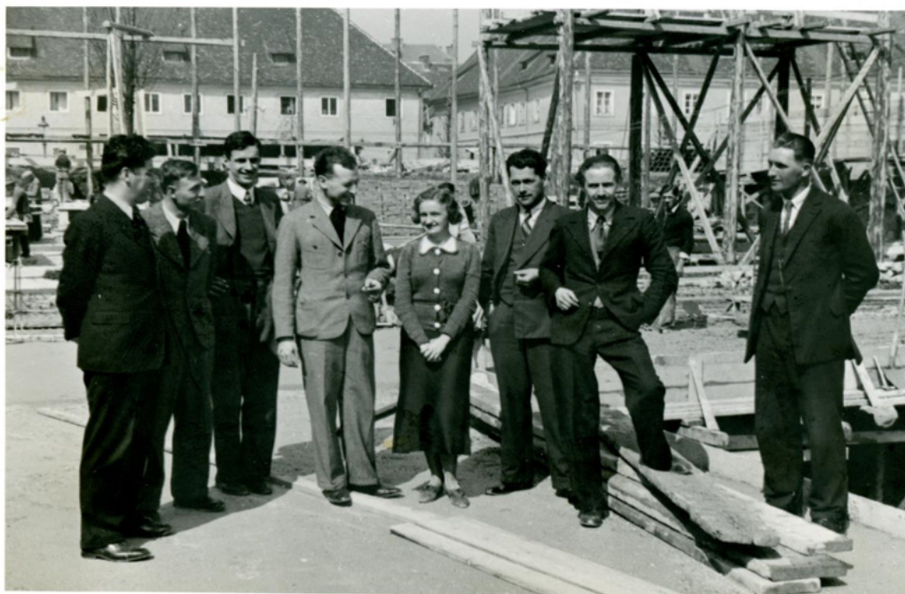
Na gradbišču NUK, 1936, Ljubljana
