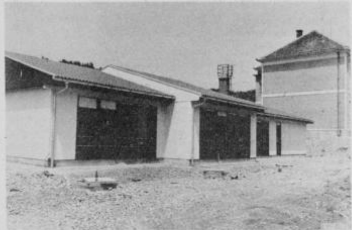
Nov otroški vrtec je za krajevno skupnost pomembna pridobitev. V objektu so tri igralnice in počivališča ter drugi spremljajoči prostori. (foto: zk)
