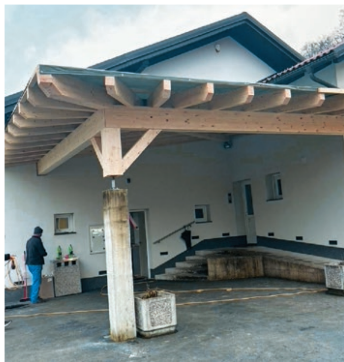
Nadstrešek na župnijskem dvorišču
