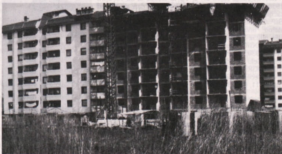
Stanovanjski blok v Žalcu gradimo po tehnologiji tunelskih opažev Outinord.
