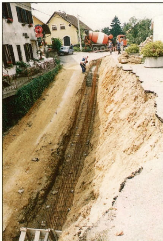
Zgoraj: Obnova podpornega zidu na Ptujski Gori. (Foto S. Kerbler)
