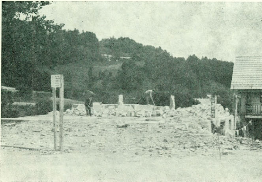
Gradbišče na Svetini
