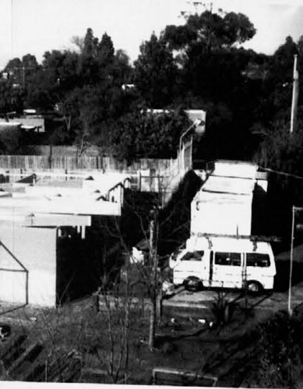
Na videz so štiri stavbe, a združene v eno. Tri stavbe so razdeljene v trideset sob s pritlikljinami, ena (na sliki so šele temelji) bo imela kuhinjo in administracijske prostore. Vse štiri stavbe bo povezovala obednica in dnevna soba. Zanimivo, da je na celotni stavbi kaj malo sten do vrha, ampak so namesto njih velika okna. Prostor je res odlično izrabljen.
