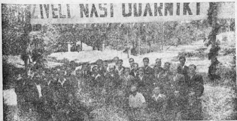
Ob zaključku gradbenih del na hidrocentrali Mariborski otok je bilo proglašanih 41 udarnikov.
