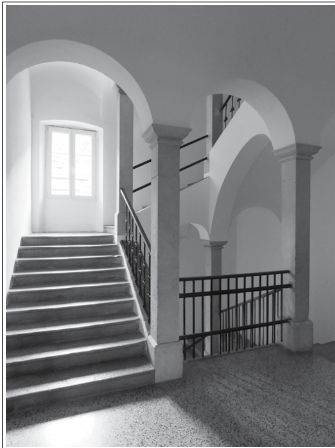
Notranje stopnišče, podprto s klesanimi slopi in zidanimi loki in oboki (Foto: Božidar Premrl).
