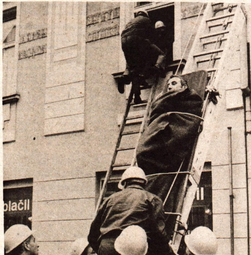
Ranjeni na varnem — KS Kranj Center je pripravila na Titovem trgu še vajo reševanja iz goreče hiše. Tehnično reševalna četa pri združenem odredu civilne zaštite občine Kranj je prikazala na kar najbolj realističen način reševanje z daljšo in krajšo lestvijo, z reševalno vrečo in zglobovno hidravlično platformo. — Foto: F. Perdan
