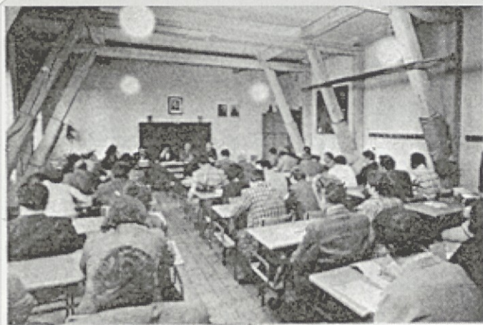
S tramovi podprti stropi v osnovni šoli bratov Štrafela v Markovcih.
