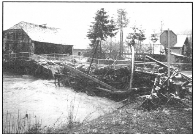
Most v Sp. Krašah je klonil pod silnim bremenom vode in naplavin (foto: F. Kotnik)
