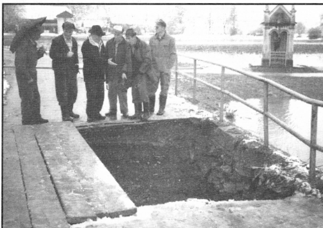
V Kokarjah je voda odnesla del cestišča pri mostu čez Dreto (foto: F. Kotnik)
