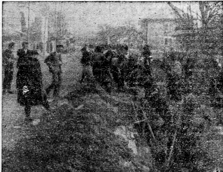
Prostovoljni delavci in delavke s terena Galjevica in Rudnik kopajo jarek za vodovodno napeljavo na Dolenjski cesti
