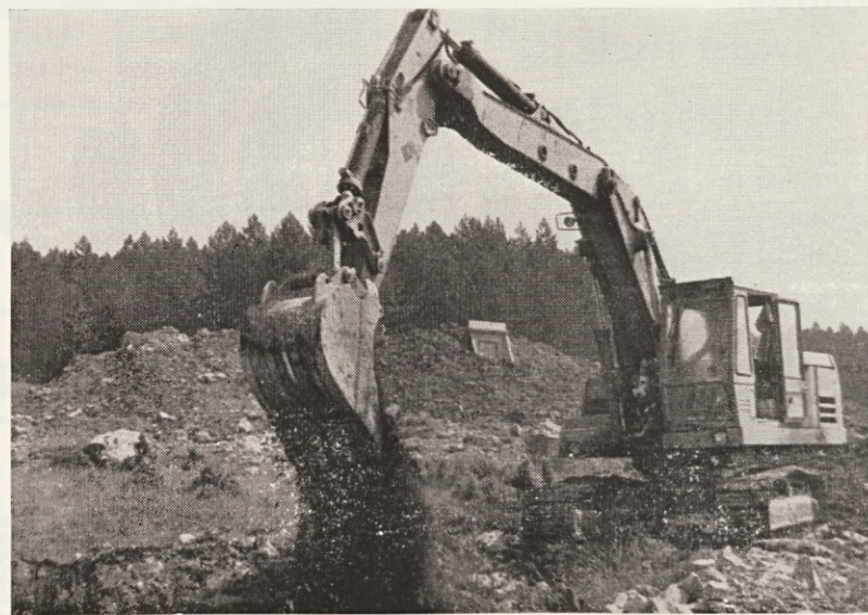
Gradnja rezervoarja za cerkniški vodovod
