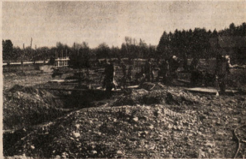
Na gradbišču klavnice je bilo zaradi slabega terena potrebno fundiranje tudi do 70 m globoko
