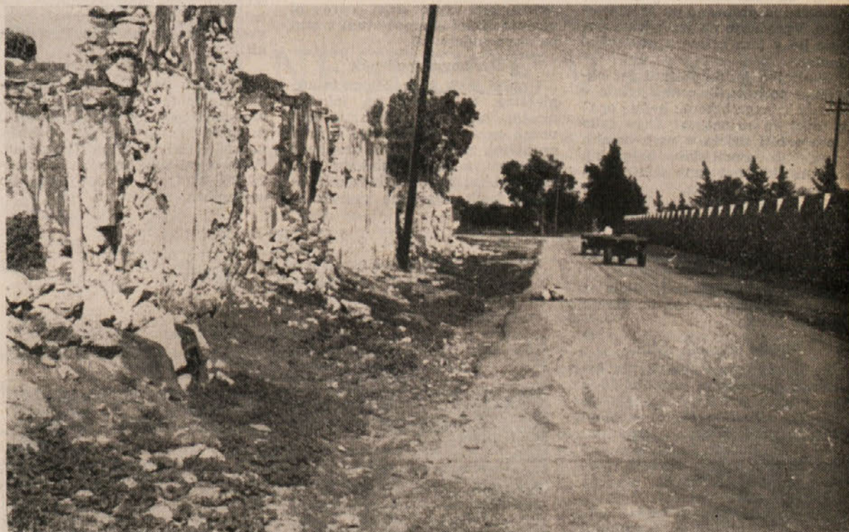
Še en pogled na ruševine mesta Barče. Potres je porušil vse, kar ni bilo solidno grajeno. Objekti, zidani iz kamna in slabe apnene malte, se potresu niso mogli upirati
