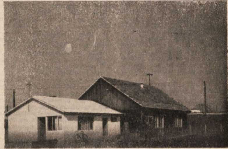
Gradbišča pisarna in delavsko naselje v Ptuju, kjer gradimo klavnico za perutnino
