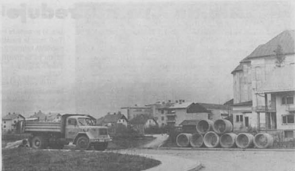
Urejevanje kanalizacije je največja investicija v Žireh. Že samo za skladišče materialov zavzema veliko prostora
