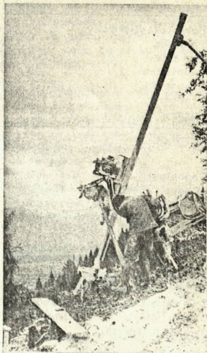
Globinsko vrtanje pri masovnem miniranju - foto ing. Čelik
