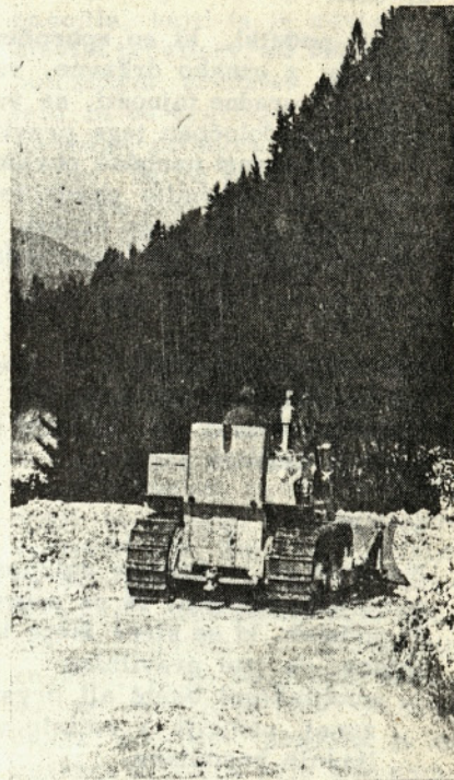
TG - 90 pri premiku na gradbišču - foto ing. Čelik
