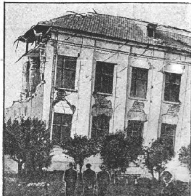
Poškodovana hiša v Strumici
