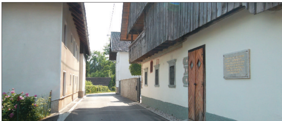
Obnovljena infrastruktura v Zagoricah, kjer se je rodil Blaž Kumerdej.
