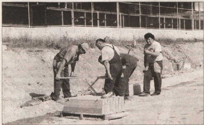
PLOČNIK IN CESTA PROTI MENIŠKI VASI - Delavci Cestnega podjetja Novo mesto so prej kot v mesecu dni zgradili pločnik, vkopali potrebne kable ter asfaltirali pločnik in cesto od topliške šole do Meniške vasi. Šolarji in vsi pešci bodo po zaslugi te skoraj 30 milijonov tolarjev vredne naložbe topliške občine hodili varneje. (Foto: B. D. G.)
