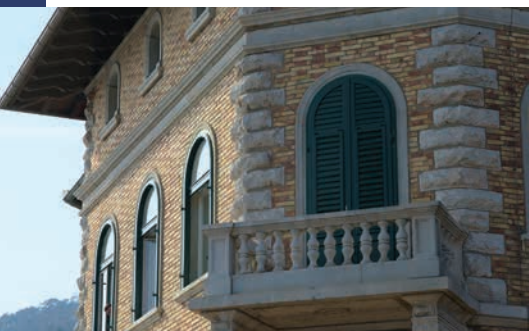
Villa Liana – dettaglio (Foto: Goran Pleić, 2022).
