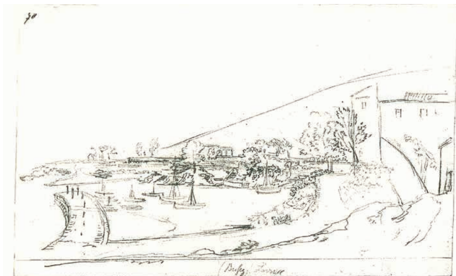
P. Nobile, Lovran, mandrač sa sačuvanim lukobranom i crkvicama sv. Trojstva i sv. Sebastijana te kućama, podignutima nad zidinama jugoistočnog ruba naselja s kulom Stubica/ Laurana, il porticciolo con il frangiflutti, le chiesette della SS. Trinità e di S. Sebastiano e le case costruite sopra le mura al limite orientale dell'abitato con la Porta marina (Bradanović, 2012, 132).
