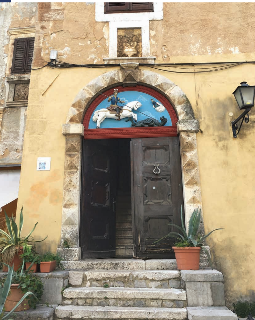
San Giorgio che uccide il drago, di fronte alla chiesa congregazionale di Laurana: è realizzato in altorilievo, sul campo di una caratteristica lunetta decorata con intagli in legno. Lo stemma (probabilmente quello del Capitano di Pisino di allora) è collocato in una nicchia appositamente costruita sopra il portale, ed è datato 1723 in numeri arabi (Bradanić, 2010, 241; Foto: Darko Darovec).
