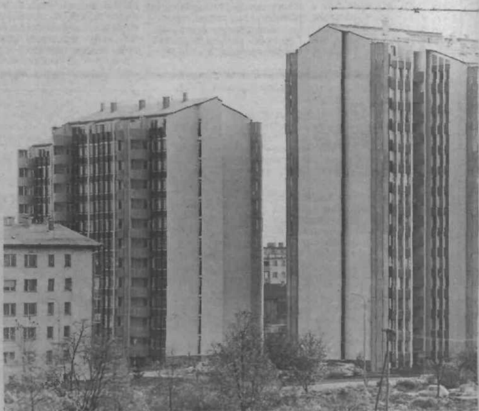
V soseski BS V/1 med Vodovodno in Glavarjevo cesto bo kmalu dobila prebivalce že druga stolpnica, konec leta pa bodo dogradili še tretjo. V soseski bo več kot 300 stanovanj, tako da bo treba kmalu misliti tudi na njihovo preskrbo z osnovnimi življenjskimi potrebščinami. Razveseljivo je, da bo v eni stolpnici tudi prostor za delo hišnega sveta in uličnega odbora SZDL. Tako bo v tej mladi soseski samoupravno in politično življenje potem lažje steklo.
