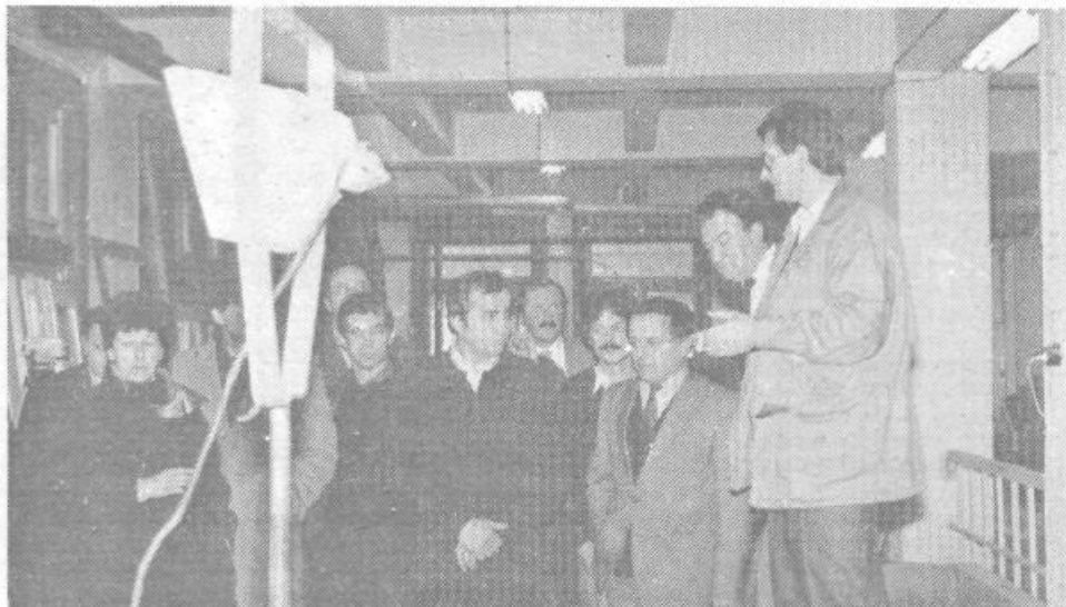
Model zadrževalnika Božna, ki ga preizkušajo v VGI Ljubljana na Hajdrihovi 28, so si ogledali vsi udeleženci nedavnega pogovora o gradnji tega pomembnega priljubljanskega vodnogospodarskega objekta (Slika: Stane Jesenovec)
