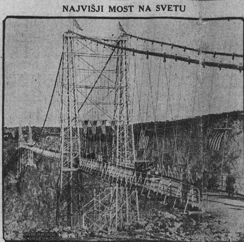
NAJVIŠJI MOST NA SVETU Pred nedavnim je bil izročen prometu most, katerega sliko vidimo zgoraj. Zgrajen je preko reke Arkansas v bližini Royal Gorge, Colo., in leži 1053 čevljev visoko nad prepadom ter je na ta način najvišje ležeči most na svetu.
