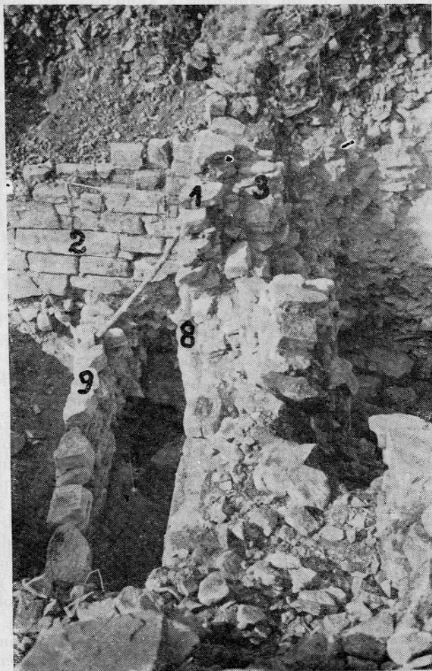
Sl. 4. Podporni zid 2 s skupino zidov 1, 3 in 4.
