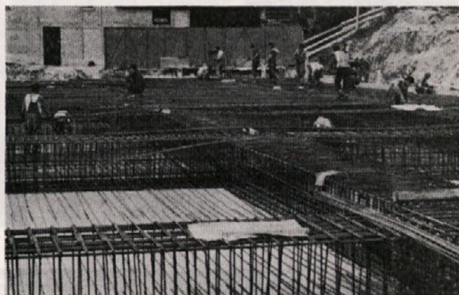
Polaganje armature 28. maja — Foto Miran Terglav
