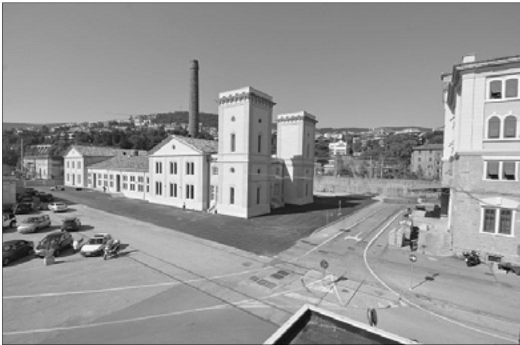
Hidrodinamična centrala v starem pristanišču
