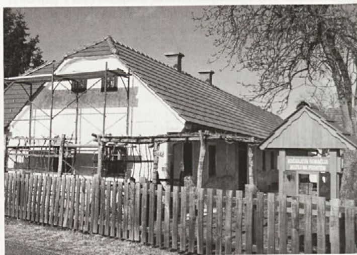
S Kočarjevo domačijo občina kandidira na razpisu LAS za pridobitev sredstev za dokončanje njene obnove.
