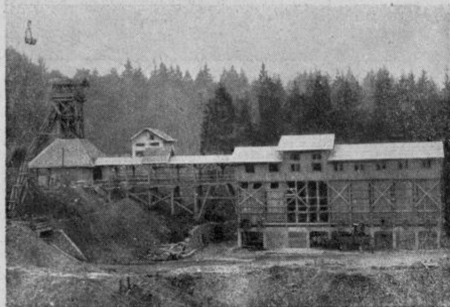
Nov jašek in separacija rudnika Pečovnik nad skladi premoga, ki so jih začeli izkoriščati pred leti
