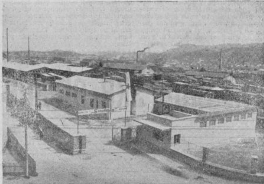
Glavni obrat lesno industrijskega kombinata »Savinja« je na Sp. Hudinji. Semkaj se bodo v bodočnosti preselili tudi vsi ostali obrati tega renomiranega podjetja
