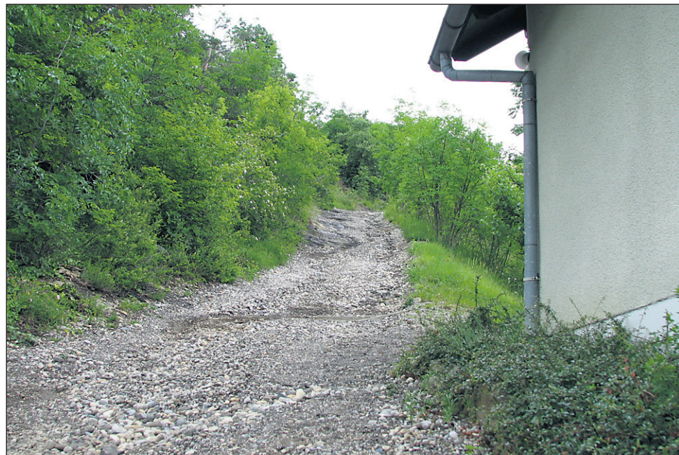
Ponedeljkov hud naliv je najbolj poškodoval gramozirane ceste po večini območij v Halozah.
