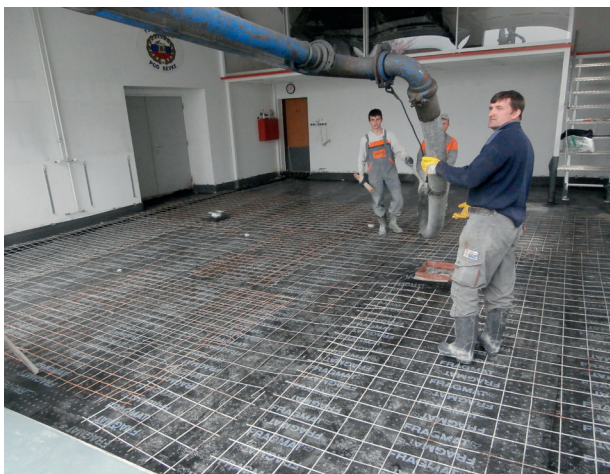
Končna izvedba tlaka
