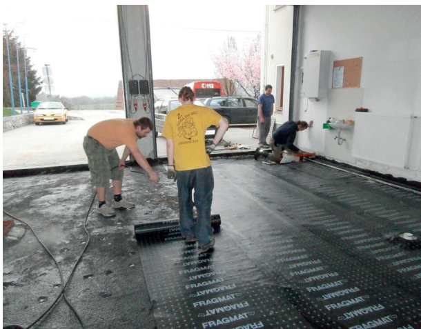
Polaganje hidroizolacije
