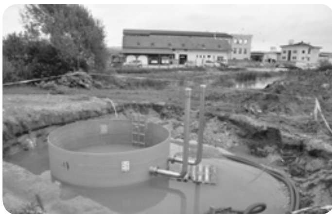
Podrt star upravni objekt in bazeni na CČN.
