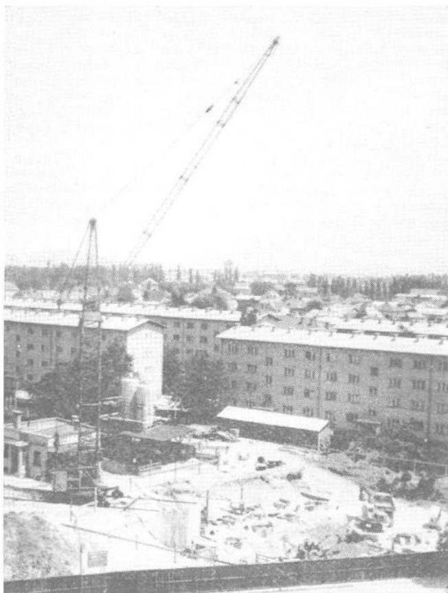
Izkopavanje temeljev za novo stolpnico ob Celovski cesti Foto S. Voličič
