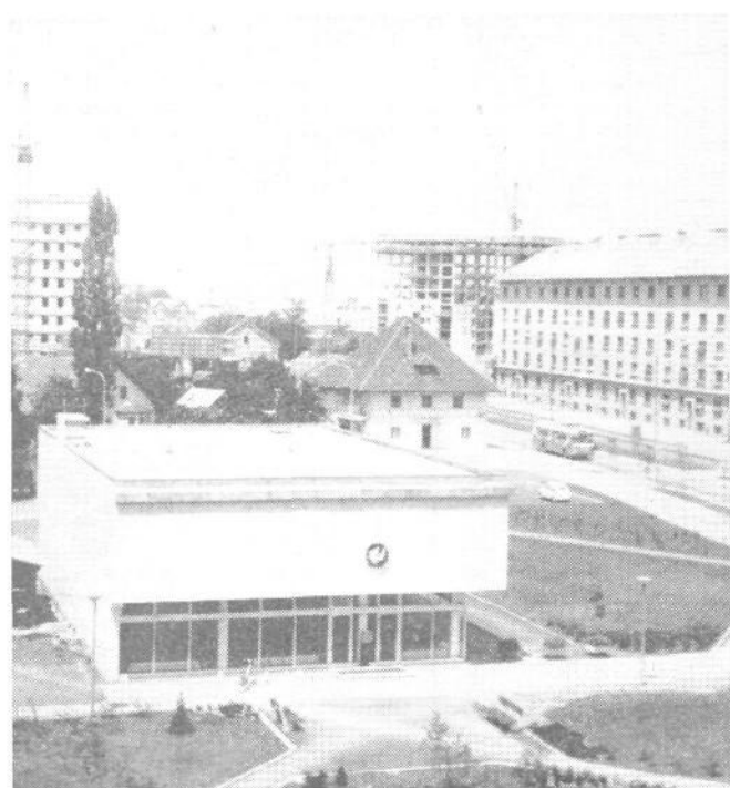
Novogradnje ob Celovski cesti
