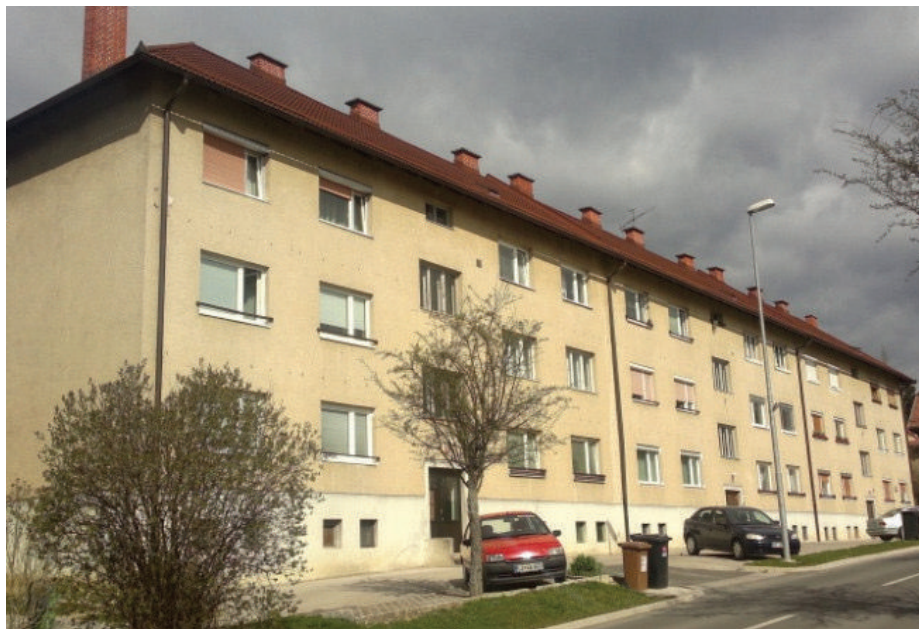
Slika 2 • Večstanovanjska stavba A.
