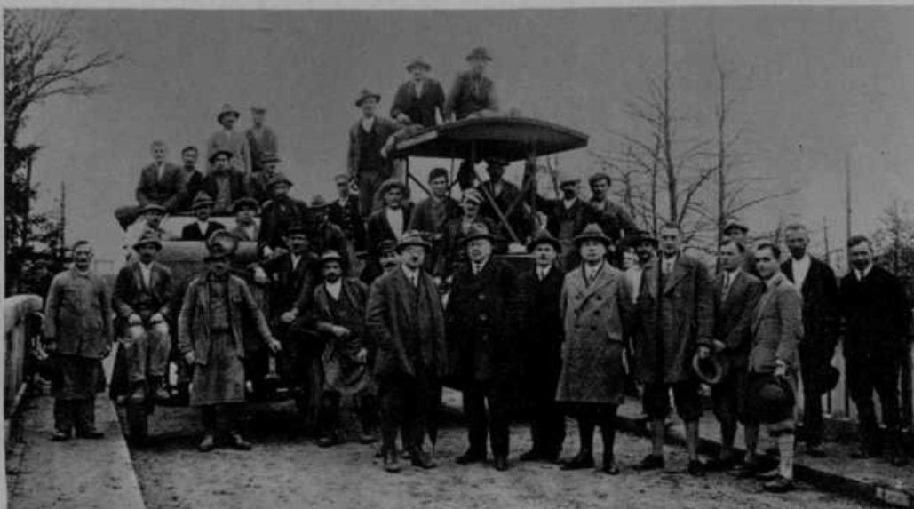
Preizkušnja novega mostu čez Kokro pri Kranju.
