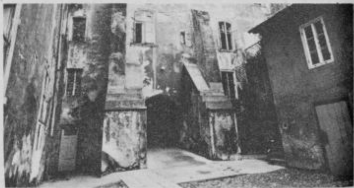
Dvoriščna stran zgradbe
