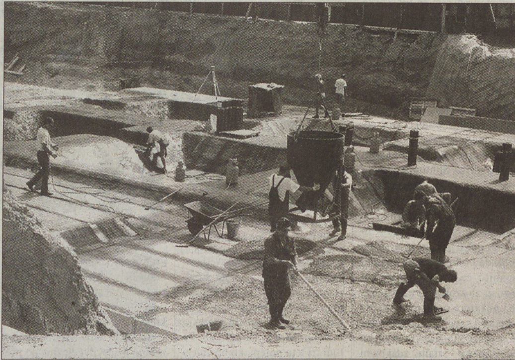
Tik za občinsko stavbo v Radencih je nastalo ogromno gradbišče.
