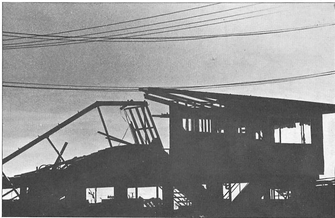
Poškodovani in razdejani domovi
