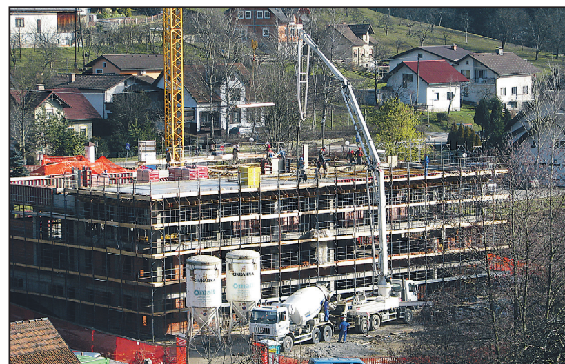
Ta teden naj bi objekt že začel dobivati streho.
