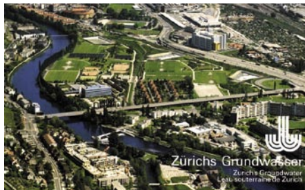
Slika 21 • Črpališče Zürškega vodovoda z zmogljivostjo 1,7 m 3 /s s ponikalnimi bazeni za aktivno zaščito z obrežnim filtratom reke Limmat v neposredni bližini prometnic in mesta
