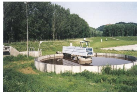
Slika 15 • Čiščenje gnojivke – naknadni usadnik na farmi Podgrad
