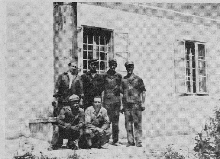
Delavci EE Gorje po uspešnem remontu parnega kotla
