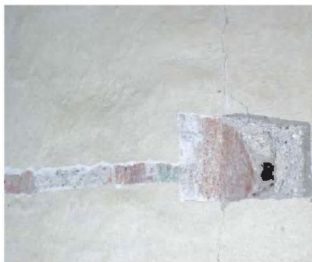
Bodovlje, cerkev sv. Petra. Sonda na južni steni v območju furlanskih slikarjv do špaleta zazidanega gotskega okna. (dokumentacija: TRIPTIH d. o. o., julij 2008)
