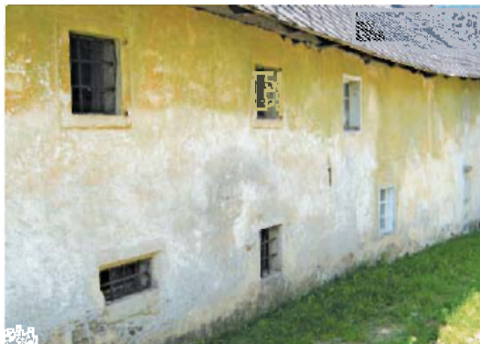
Poznogotska okna iz 16. in 17. stoletja v severovzhodni fasadi nadstropne Zenskove hiše v Veštru. (foto: France Stukl)
