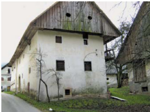
Vrbanov nadstropni grunt v Brodeh; najstarejši del iz 16. in 17. stoletja z ohranjeno strmo streho. (foto: France Štukl)
