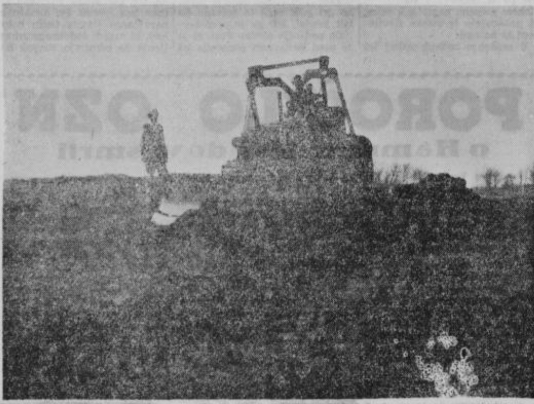
Buldozer na delu.
