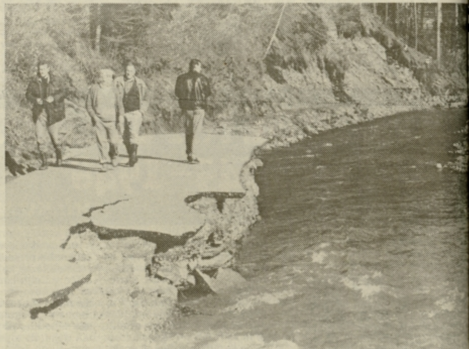
Tudi to cesto med Lučami in Podvolovljekom so že začeli popravljati v teh dneh, tako bo kmalu prevozna vsaj za osebne avtomobile.
