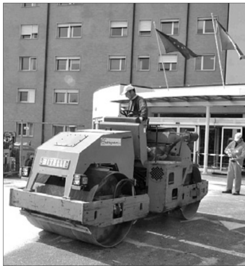
Preurejajo prehod za pešce pred vhodom v splošno bolnišnico
