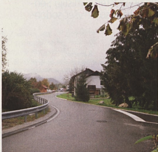
Prenovljen odsek ceste v Stopčah. Foto Občina Šentjur
